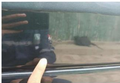
Cat Pintu Kiri Tidak Rata Dan Tidak Rapi
