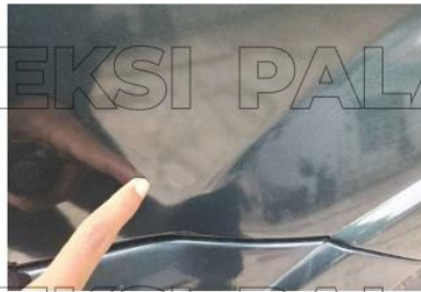
Dempul Retak Di Quarter Kanan
